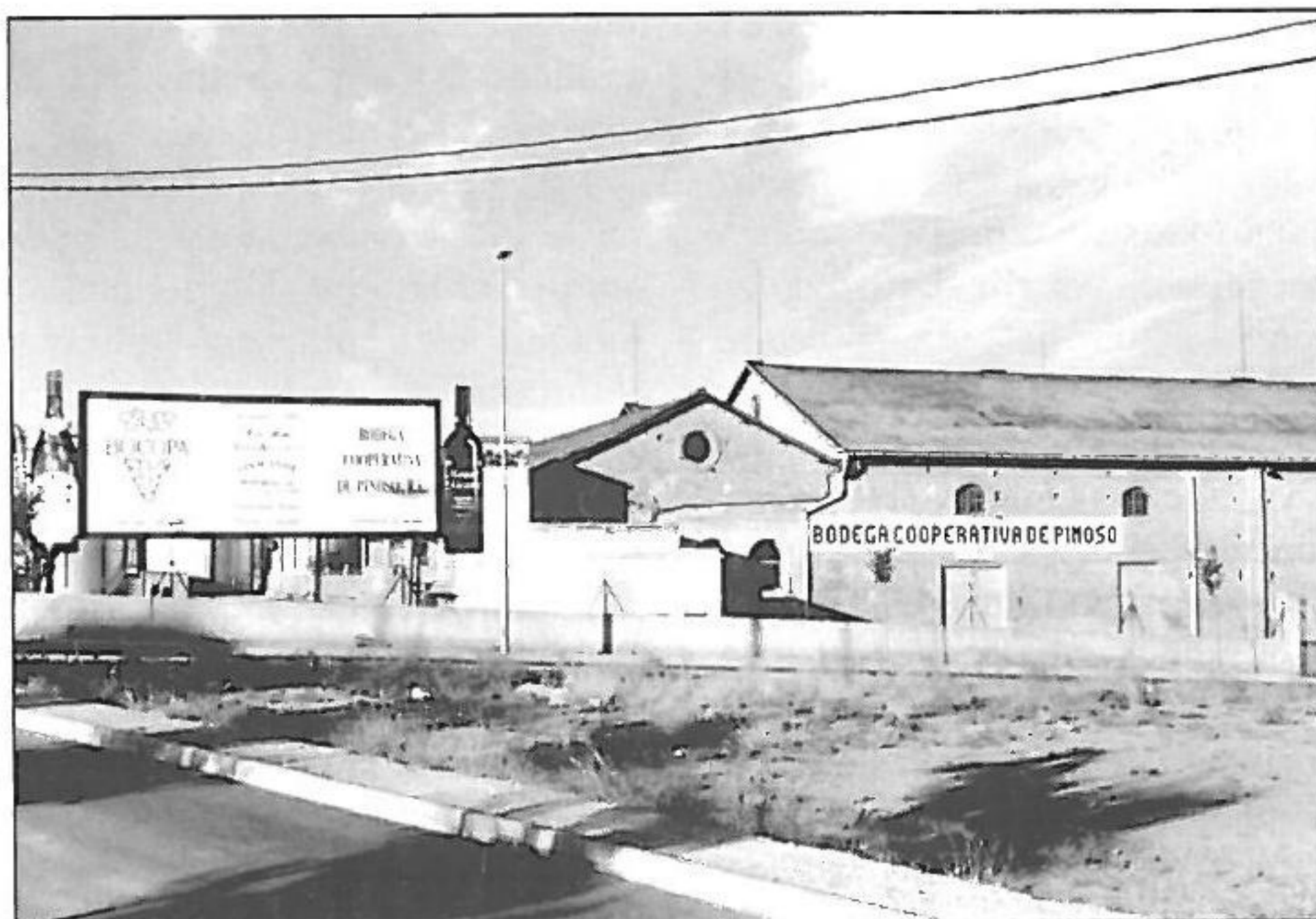
Bodega Cooperativa de Pinoso
